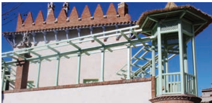
La façana recuperada de la casa Puig i Cadafalch
