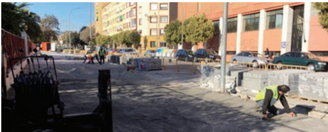
Obres al Camí del Mig, just davant del centre escolar homònim
