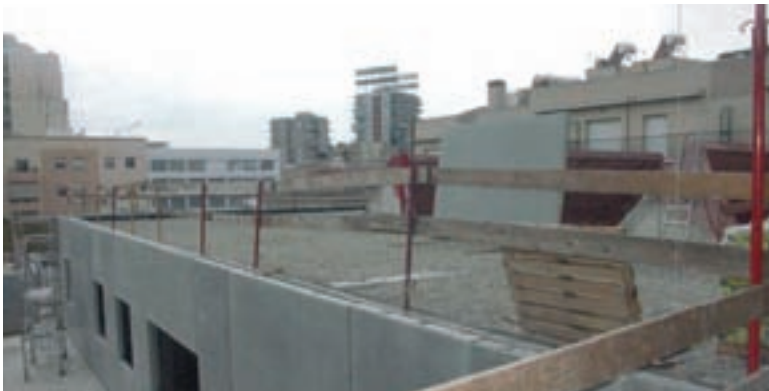
Estat de les obres de la futura escola Montserrat Solà
